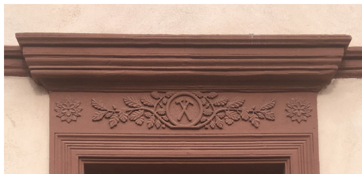
Enduit à la chaux de la façade de l'ancienne maison de direction de Stiring-Wendel
