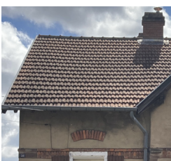
Tuiles mécaniques en terre cuite rouge uni avec un modèle dit « à double côte », d'une densité de 12 à 14 unités au m 2
