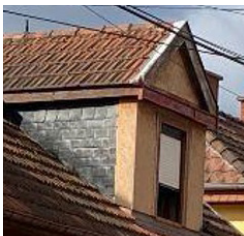
Utilisation d'ardoise naturelle, pour l'habillage des joues des lucarnes, avec pose à pureau entier
