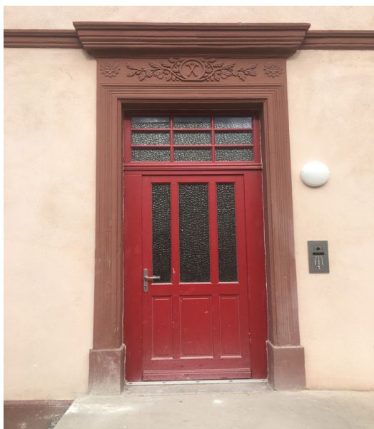
Extrait de la porte de l'ancienne maison de direction de Stiring-Wendel
