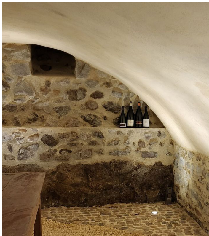
Cave ayant une voûte en pierre rénovée avec son nouvel enduit à la chaux et rejointement à la chaux entre les pierres - Source : Terre & Habitat écologique
