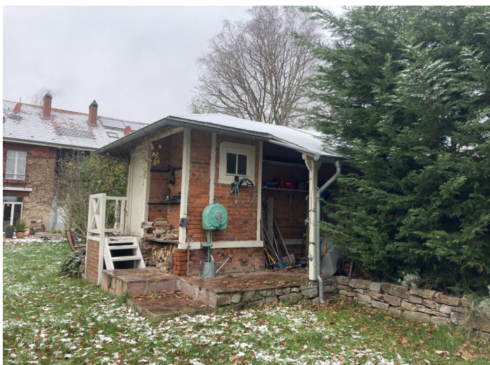
Annexe mitoyenne de la maison d'ingénieur des mines
